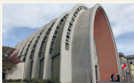
Esta iglesia fue destruida por el terremoto de Chillán (1939). Se reconstruyó con una estructura antisísmica y resistió el terremoto de 2010 con daños estructurales menores.
